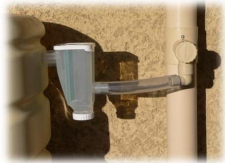
3.- Installer le FILTRE en vissant l'écrou depuis l'intérieur de la cuve en laissant le joint sur le filetage.
